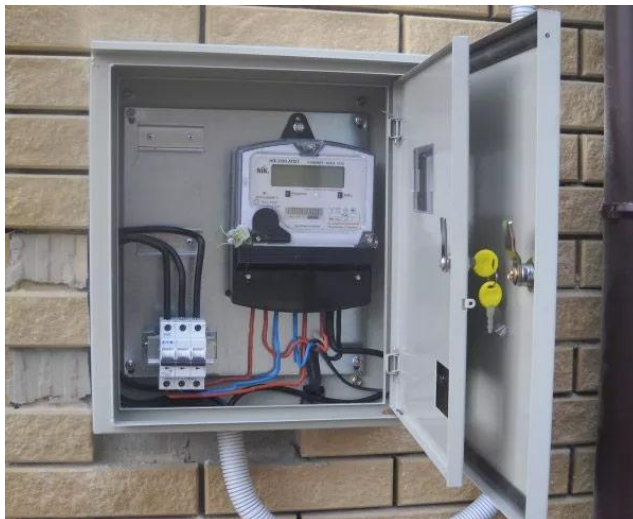
Рисунок 14.10 - Подключение СИП к автомату
