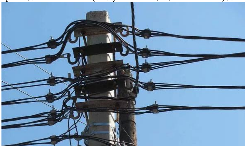
Рисунок 14.1 – Монтаж СИП на опорах
